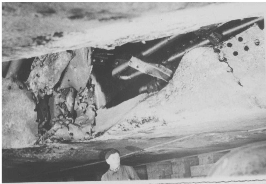
*Photo prise en cale sèche sous la coque. La taille de l'ouvrier donne l'échelle d'une des brèches. On voit à l'arrière plan la ligne de tins. Au delà de la brèche les réchauffeurs.*
